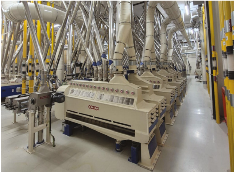
Semolatrici Ocrim installate presso Molini Valente.
