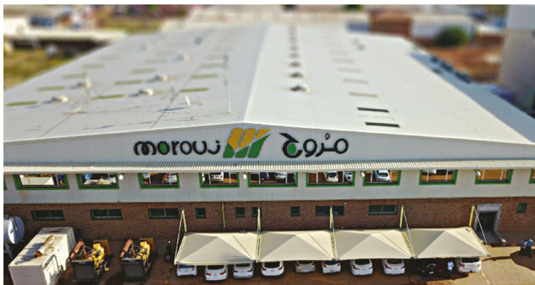
Vista dall'altro degli impianti di Morouj Commodities L.T.D. (Ocrim).
