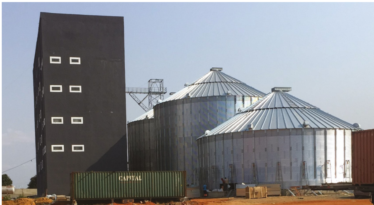
Impianto esterno Ocrim per Sanabel Group International.
