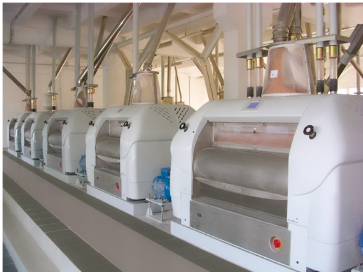
Kostanay (Kazakhstan) - piano laminatoi dell'impianto di Kostanay Melkombinat (Ocrim).
